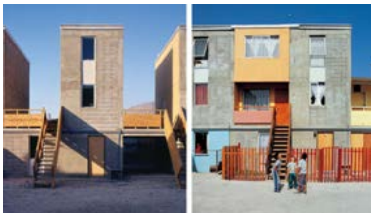
Structure de base des logements et extension
